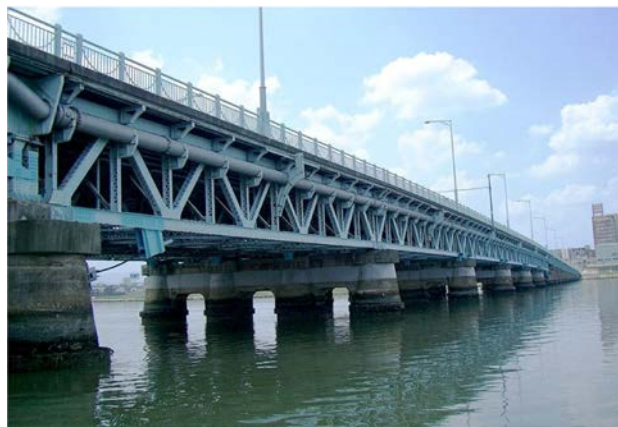
写真 1 対象橋梁全景
