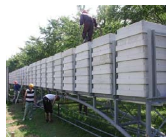
写真-6 RCFTによるボウ・ストリング・アーチ
