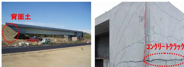
写真-1 橋台躯体のひび割れ位置
