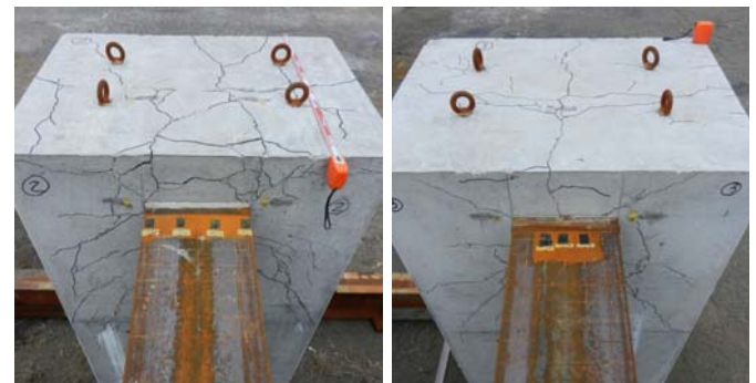
写真-3 実験後のクラック発生状況
