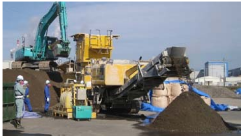
写真-5 セメント改良土製造状況
