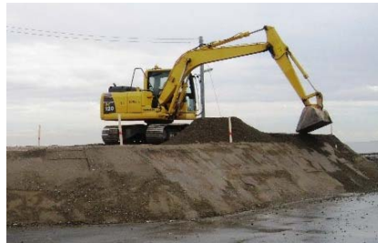
写真-6 敷均し状況
