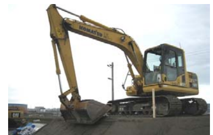
写真-8 法面整形状況
