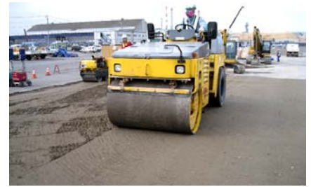
写真-7 転圧状況
