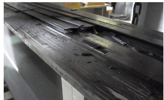
図-3 上フランジに接着したCFRP板の層間はく離
