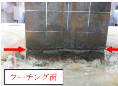
写真-1 柱基部の腐食欠損
