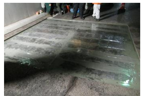
写真-3 試験施工敷設完了
