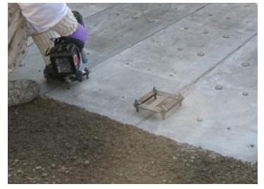
写真-2 UFCパネル固定治具
