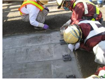
写真-1 間詰め工
