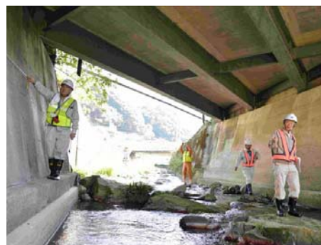
写真 4 三者合同点検状況
