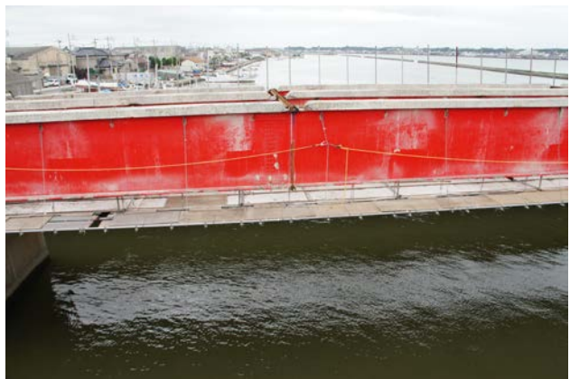
写真－5 上フランジに設置した仮支材 (隣接径間における作業状況)
