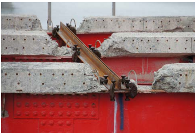
写真－6 上フランジに設置した仮支材 (隣接径間における作業状況)
