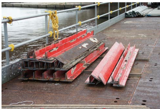
写真－4 撤去された対傾構の一部
