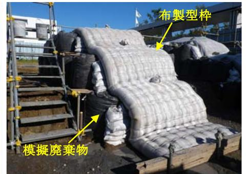
写真-1 布製型枠による隔離層構築
