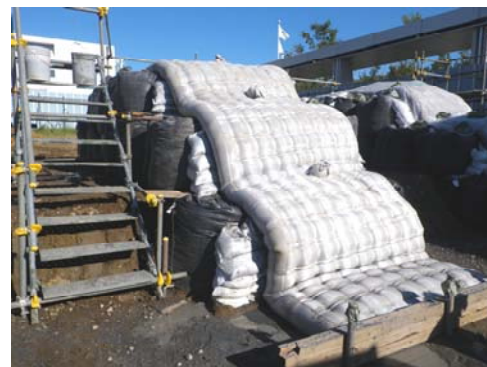
写真-1 布製型枠による隔離層
