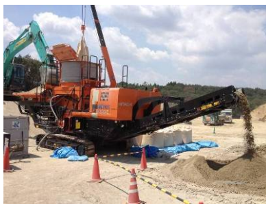
写真-1 混合状況
