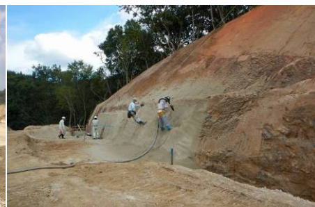
写真-2 吹付け状況
