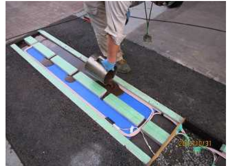
タイプ C コイル埋戻し状況
