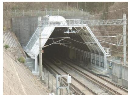
図1 ダクト付トンネル緩衝工
