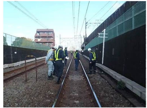
図3 日中巡回により継目部の調査をしている様子
