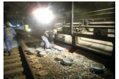
写真-3 分岐器前後のバラスト散布
