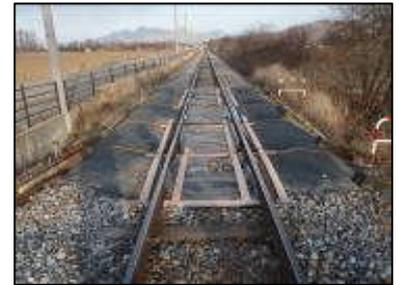
写真-1 断熱工法
