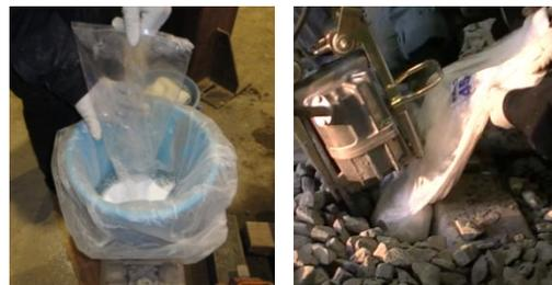
図1 充填材の混合・流し込み
