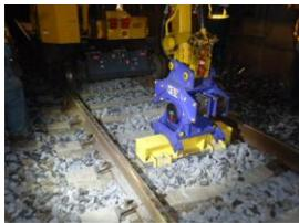
写真-3 加振施工状況
