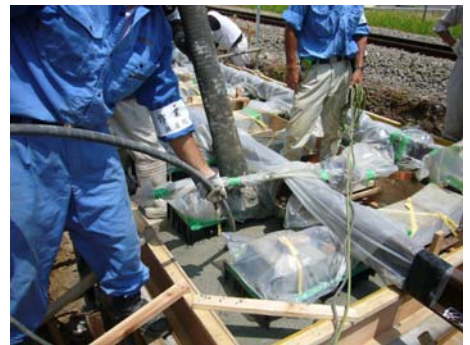
写真-2 打設状況
