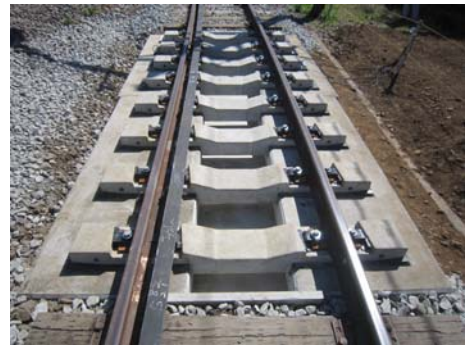
写真-3 施工完了状況
