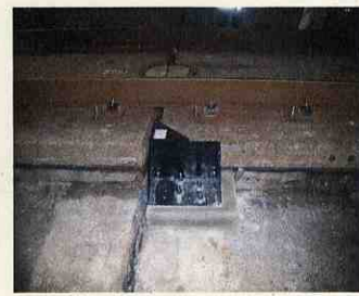
写真-4 敷設状況
