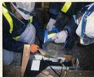
写真-3 モルタル充てん
