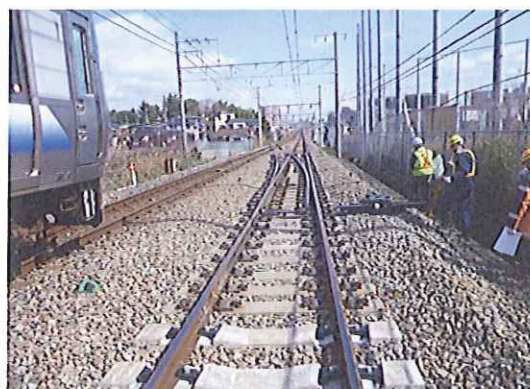
写真-2 分岐器敷設(施工後)
