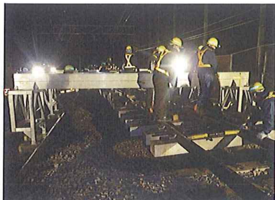
写真-1 分岐器据付け状況
