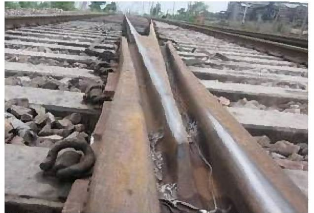
図 1 分岐器 (クロッシング部)
