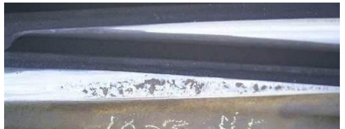
図1 マンガンクロッシング踏面の損傷例
