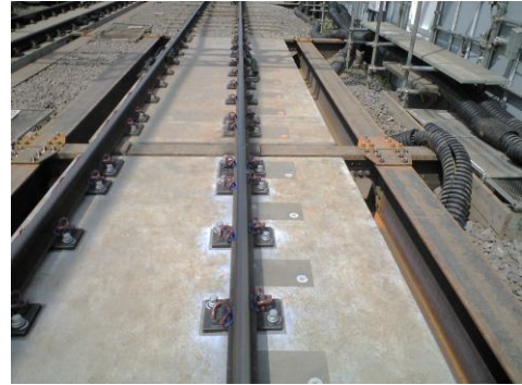
写真1 締結装置敷設状況
