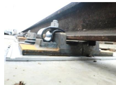
図 3 直結 8 形締結装置（曲線外軌用）
