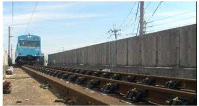
図-5: 本締結装置の敷設状況
