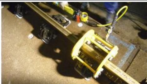
図-4: 本締結装置の圧締に使用する油圧装置
