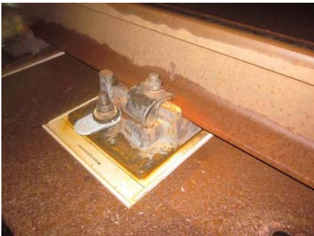
図4 締結装置(直結8形)
