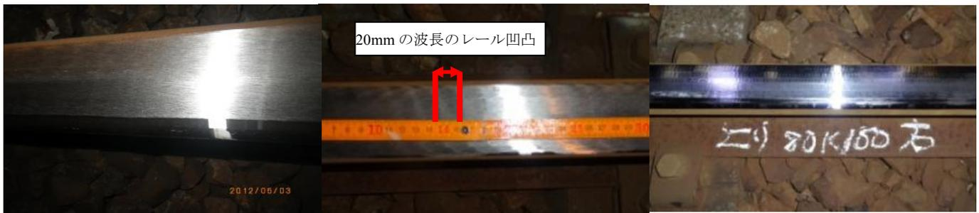
図-1 良好なグラインディング施工
