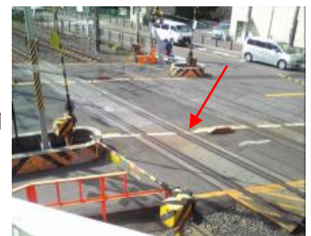
写真-2 連接軌道踏切
