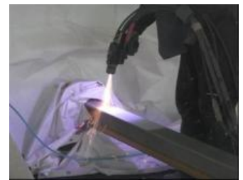
写真-1 溶射の様子
