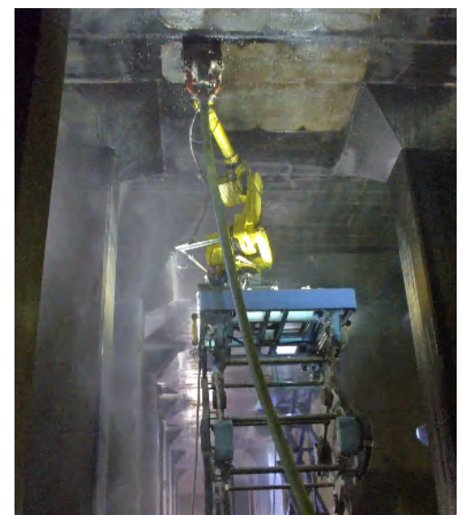
写真-4 施工状況（塗膜除去）
