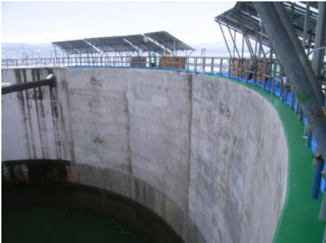
写真-4 修繕後の状況
