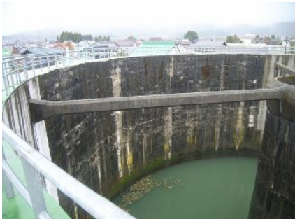
写真-1 サージタンク内壁
