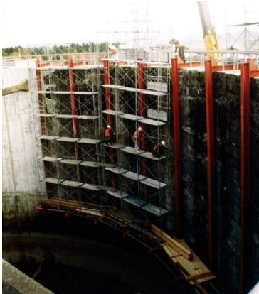
写真-2 枠組足場
