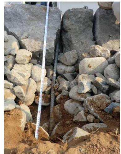
写真-2 補強材の挿入状況
