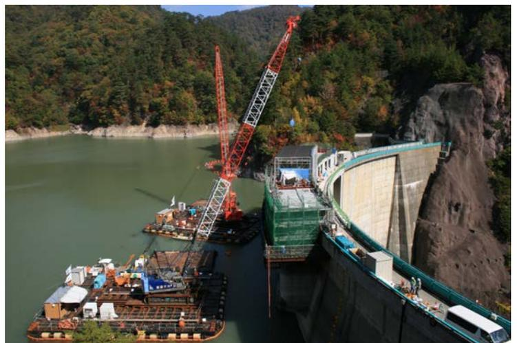
写真-3 クレーン台船2台の施工状況
