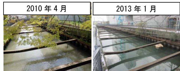
写真 2 検討箇所の現況
