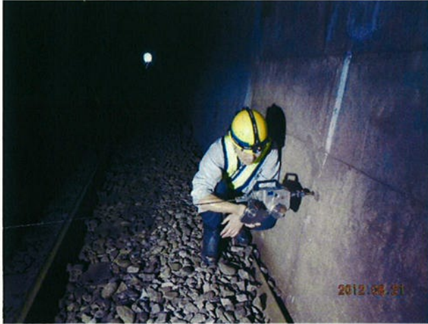
写真1 トンネル内空測定状況
