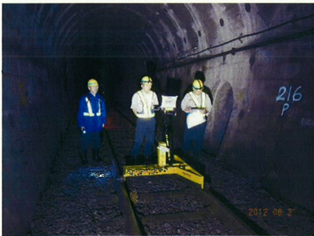
写真2 トンネル断面測定状況
