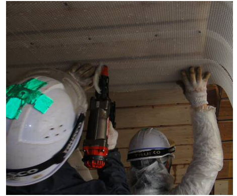
写真-2 コンクリートピン施工状況
