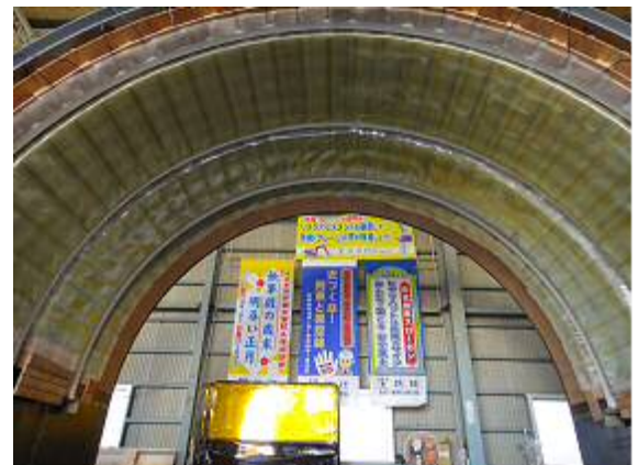
写真-3 施工試験完了
