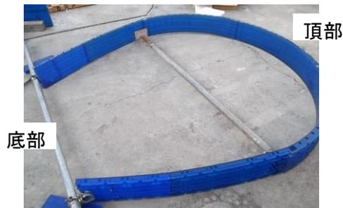
写真-2 インバートコンクリート仕上げの馬蹄形対応の例
