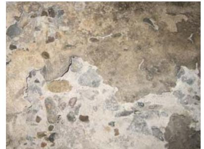
写真-1 覆工コンクリート劣化状況
