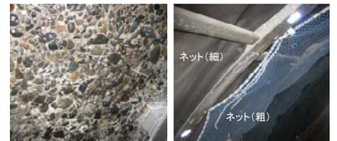
写真-5 未施工箇所の剥落防止対策
