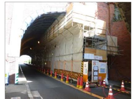
写真-4 作業足場設置状況 (片側交互通行による道路供用施工)
