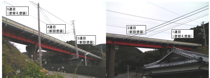
図.1 ふっ素樹脂塗料が採用された橋梁
