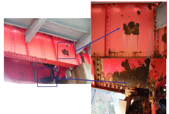
(a) 主桁腹板
