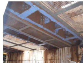
写真3 下り線桁下部
