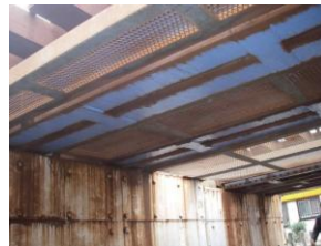
写真2 上り線桁下部
