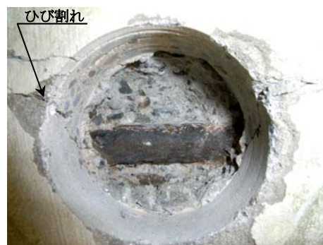
写真-2 鉄筋目視調査状況
