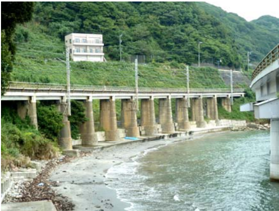
写真-1 山生橋りょう全景
