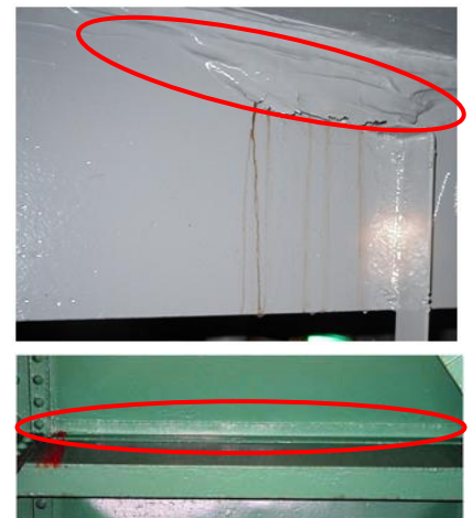
写真5 補修イメージ (上: シーリング工 下: 当て板工)
