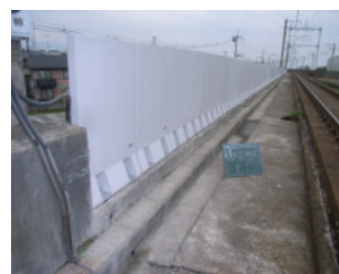
外観(線路内側)
