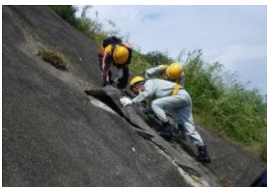
図-2 モルタル吹付工せり出し
