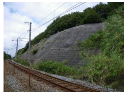
図-1 のり面工全景
