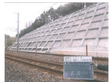
図-8 復旧対策状況
