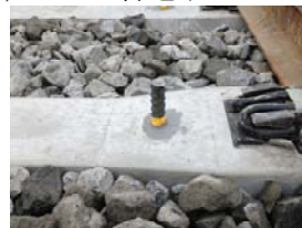
写真-1 アンカー設置状況
