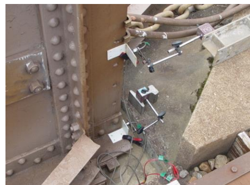
図1. 桁端の水平変位計測状況
