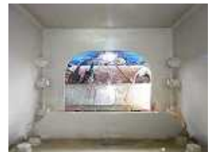
写真-5 切欠き施工後
