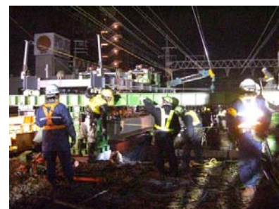
写真-5 桁交換作業中
