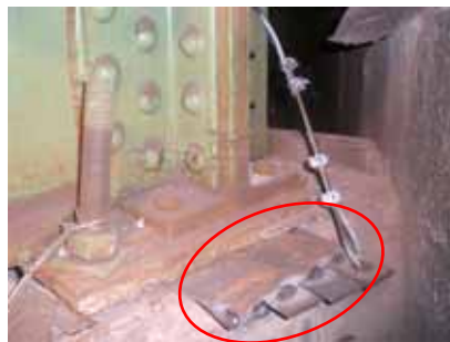
写真-3 応急修繕
